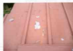
金属たて葺き (既存屋根に構造用合板施工です。)
